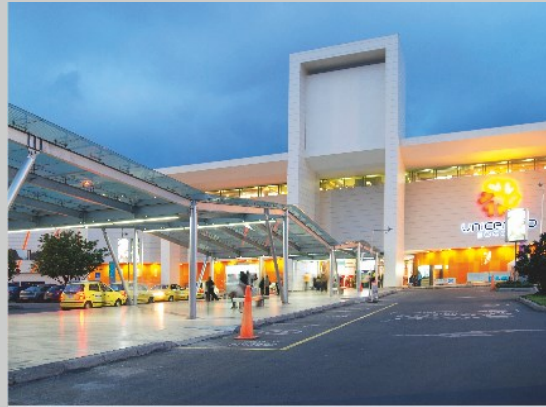
Remodelación C.C. Unicentro - Bogotá
