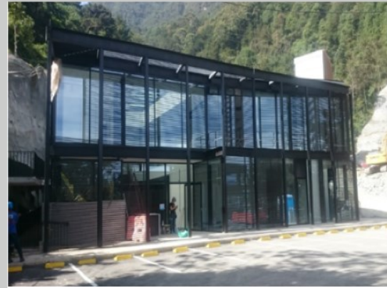
Túnel de Oriente - Antioquia
