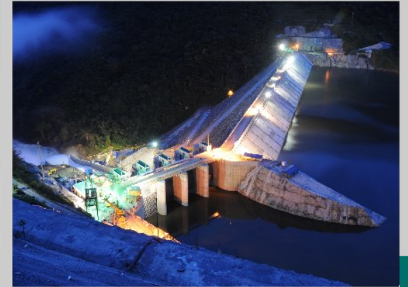
Proyecto Hidroeléctrico Porce III - Amalfi / Antioquia
