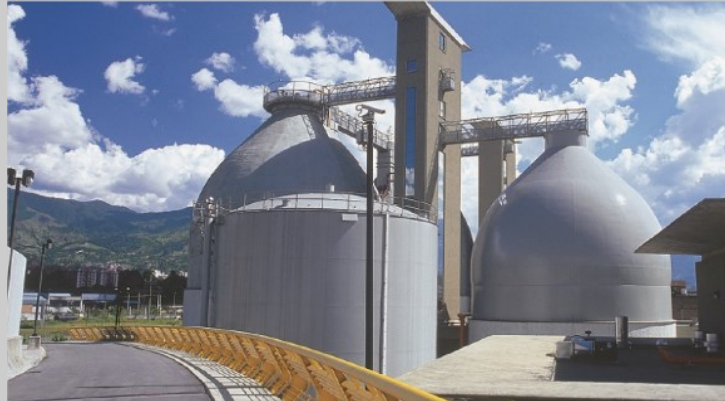
Planta de tratamiento de aguas San Fernando - Antioquia
