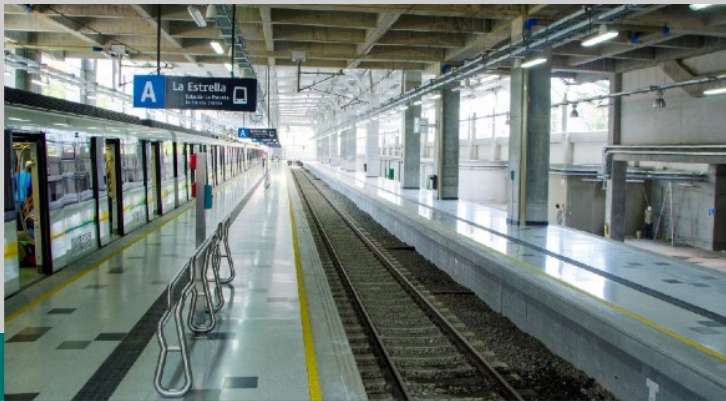
Estación Metrocable La Estrella - Antioquia
