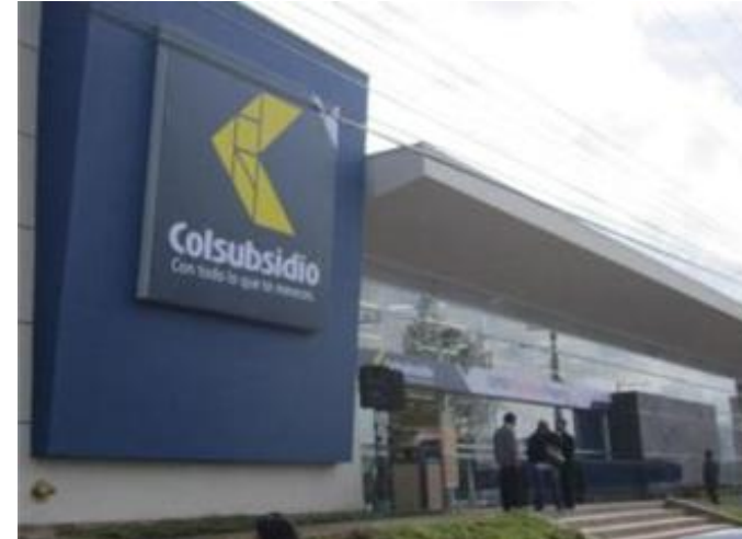
Colsubsidio – Maiporé Construcción Soacha – Cundinamarca. Colsubsidio – Villa María Construcción Zipaquirá - Cundinamarca.
