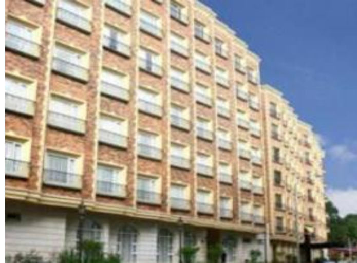
Apartahotel Dann Carlton Calle 94 Construcción Bogotá.
