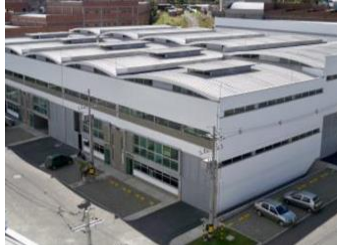
Parque Empresarial Promisión Gerencia y Construcción de obras civiles. Cliente: Constructora Promisión S.A La Estrella- Antioquia 2009
