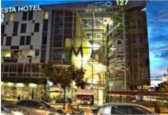
Hotel Sonesta Construcción Bogotá.
